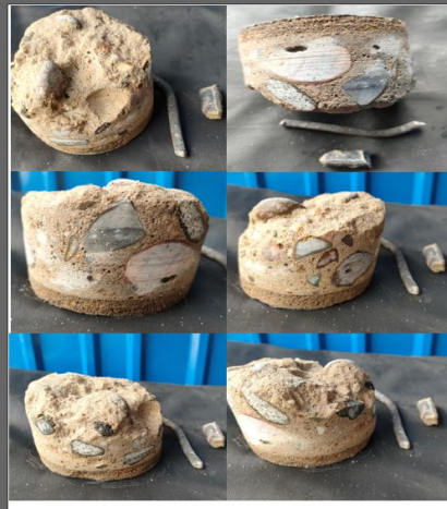
Hasil Coredrill Kolom Beton (K2)
