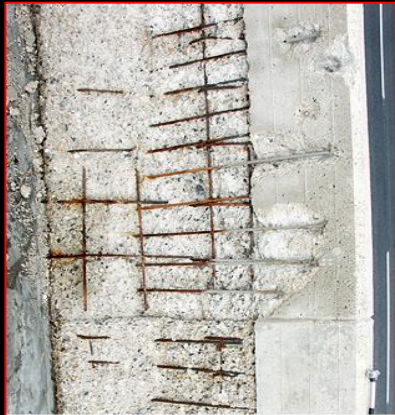
Permukaan beton telah terkarbonasi (tidak berwarna/transparan)
