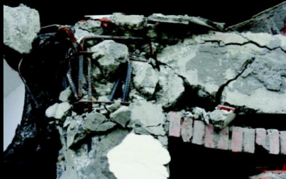
Sambungan kolom dan balok
