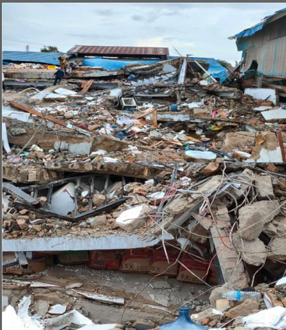
Pelat Beton runtuh total
