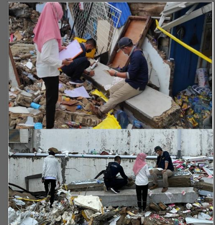
Pengujian Kolom Beton dengan Hammer Test (Dinas PUPR Kab. Banjar)
