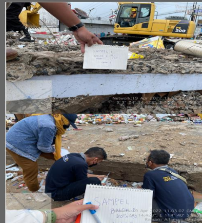
Pengujian Balok Beton dengan Hammer Test (Dinas PUPR Kab. Banjar)
