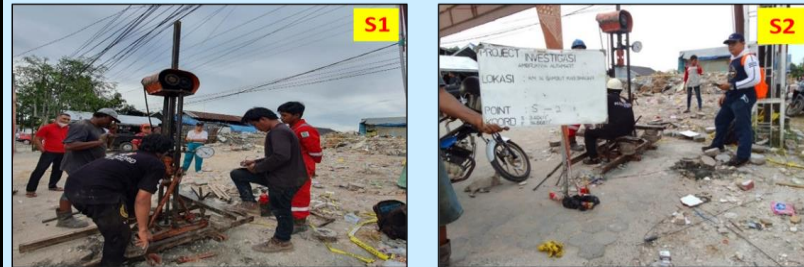
Sumber: Foto dari Tim Ahli Fakultas Teknik ULM Pengujian Sondir di lokasi runtuhnya bangunan
